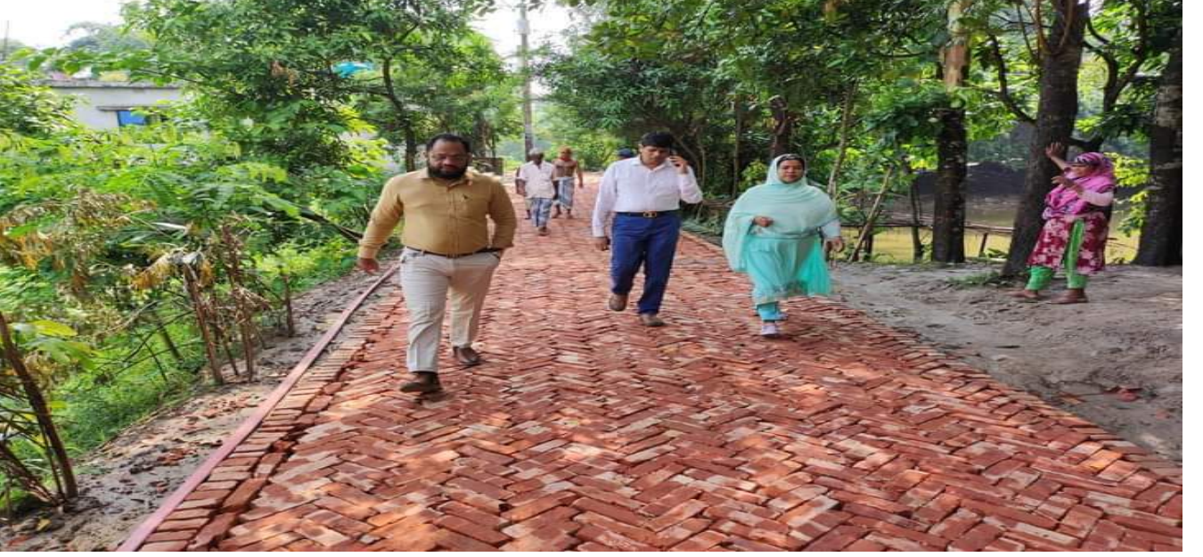
চিত্রঃ ০৩ উপপ্রকল্প পরিচালক, সহকারী প্রকৌশলী ও উপজেলা প্রকল্প বাস্তবায়ন কর্মকর্তা কর্তৃক ২০২১-২০২২ অর্থ বছরে মুন্সিগঞ্জ জেলার লৌহজং উপজেলায় খিদিরপাড় ইউপির পিংগনালী পাকা রাস্তার মোড় হতে মালনী জামে মসজিদ হয়ে ফুলকচি সীমবাগ পর্যন্ত রাস্তা হেরিং বোন বন্ড (এইচবিবি) করণ এবং গাওদিয়া ইউপির পশ্চিম পালগাঁও জামে মসজিদের নিকট পাকা ব্রীজের সামনে থেকে তিন রাস্তার মোড় পর্যন্ত রাস্তা হেরিং বোন বন্ড (এইচবিবি) করণ প্রকল্প পরিদর্শন।
