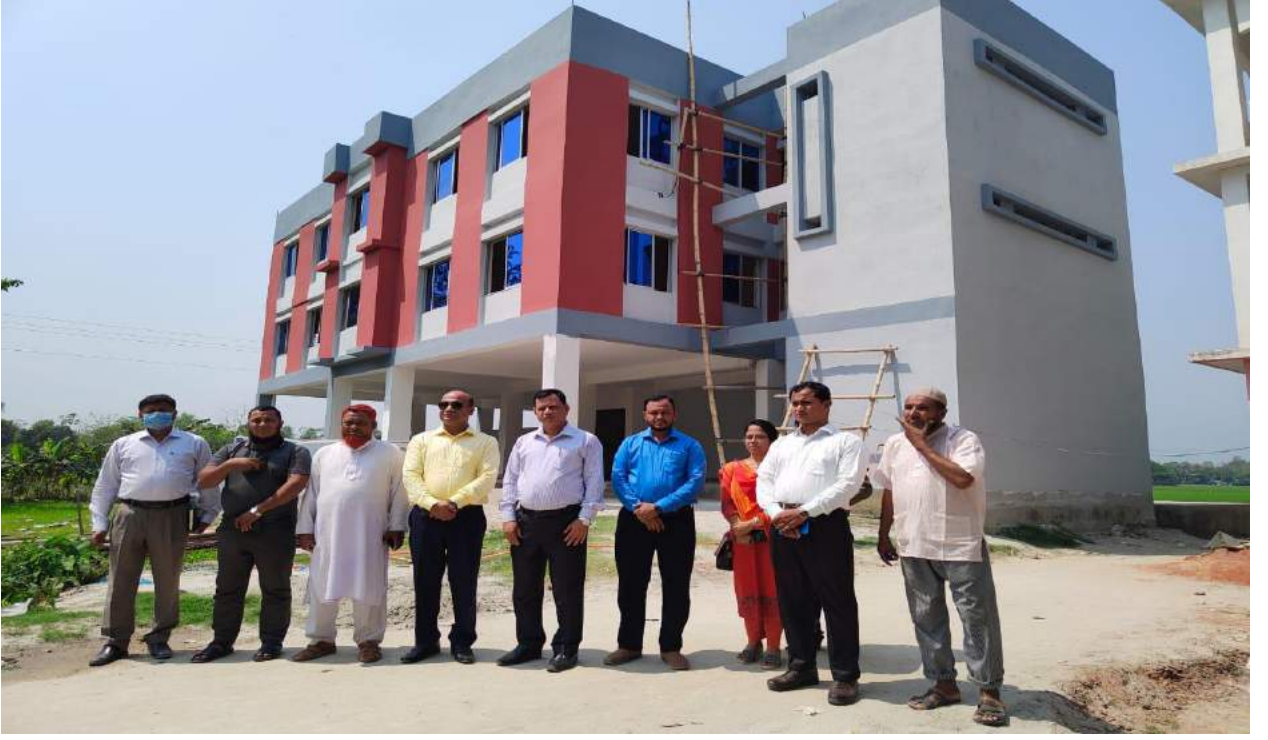
চিত্রঃ ০১ জনাব অঞ্জন চন্দ্র পাল, প্রকল্প পরিচালক এবং জনাব সাইদুল ইসলাম, সহকারী প্রকৌশলী এর কুমিল্লা জেলার নাঙ্গলকোট উপজেলাধীন আজিয়ারা উচ্চ বিদ্যালয় বহুমুখী ঘূর্ণিঝড় আশ্রয়কেন্দ্র নির্মাণ প্রকল্পস্থল সরেজমিনে পরিদর্শন।
