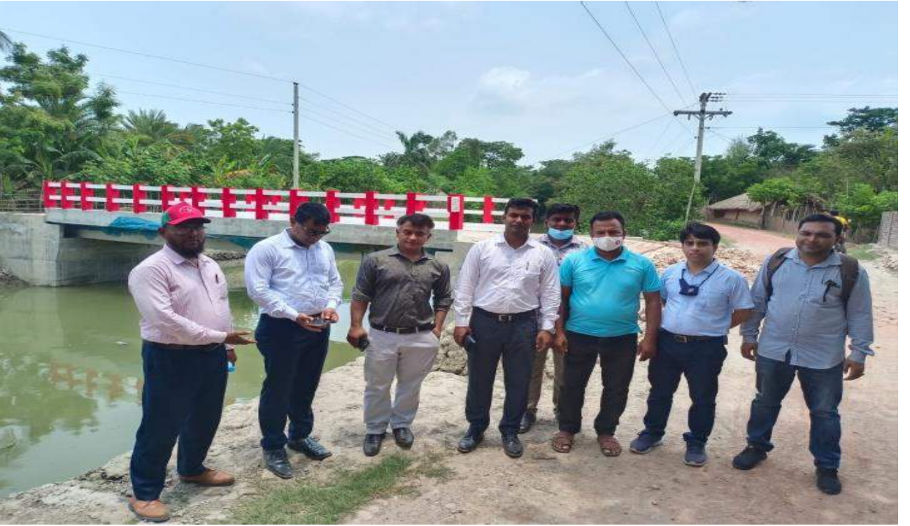
চিত্রঃ ০৪ জনাব মোঃ ইউসুফ আলী, উপপরিচালক, স্থানীয় সরকার মন্ত্রণালয়, খুলনা কর্তৃক খুলনা জেলার দাকোপ উপজেলায় নির্মিত সেতু পরিদর্শন।
