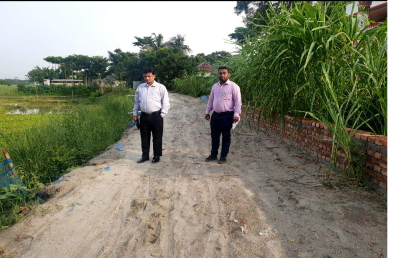
চিত্রঃ ০৪ জনাব মোঃ আব্দুর রহমান, জেলা ত্রাণ ও পুনর্বাসন কর্মকর্তা, ঢাকা কর্তৃক দোহার উপজেলার, সুতারপারা ইউনিয়নের কাজিরচর মধুরচর পাকা রাস্তা হতে ব্রিজ হয়ে ভূমিহীনদের আবাসন পর্যন্ত মাটির রাস্তা পুনঃনির্মাণ কাজ পরিদর্শন।
